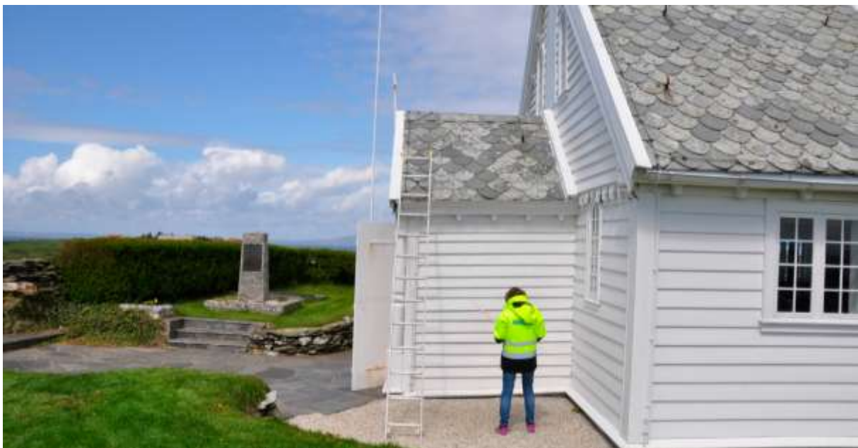
Rehabiliteringsarbeid Kvitsøy kirke
