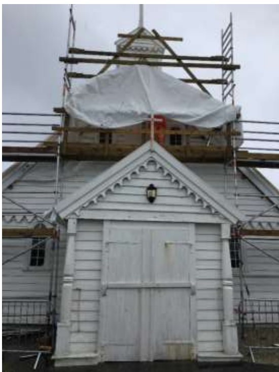
Rehabiliteringsarbeid Kvitsøy kirke
