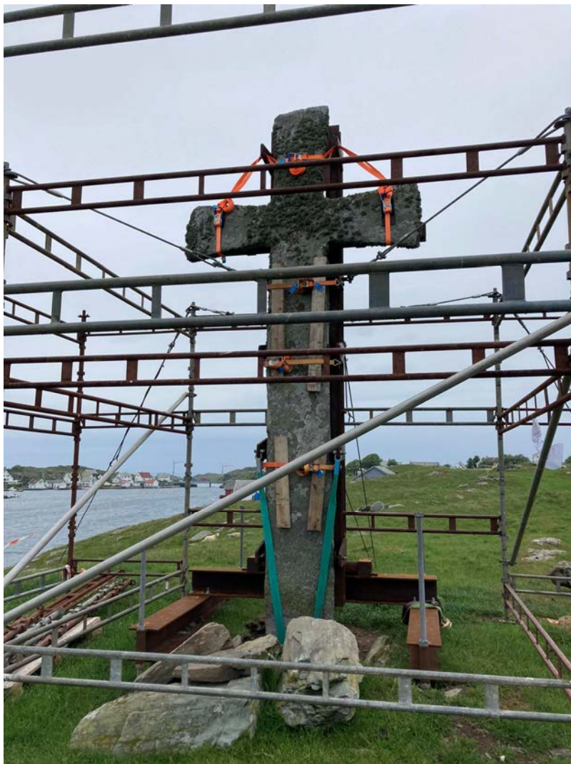
Foto TRAFO, korset sikret i forbindelse med arbeid på RogFast prosjektet.
