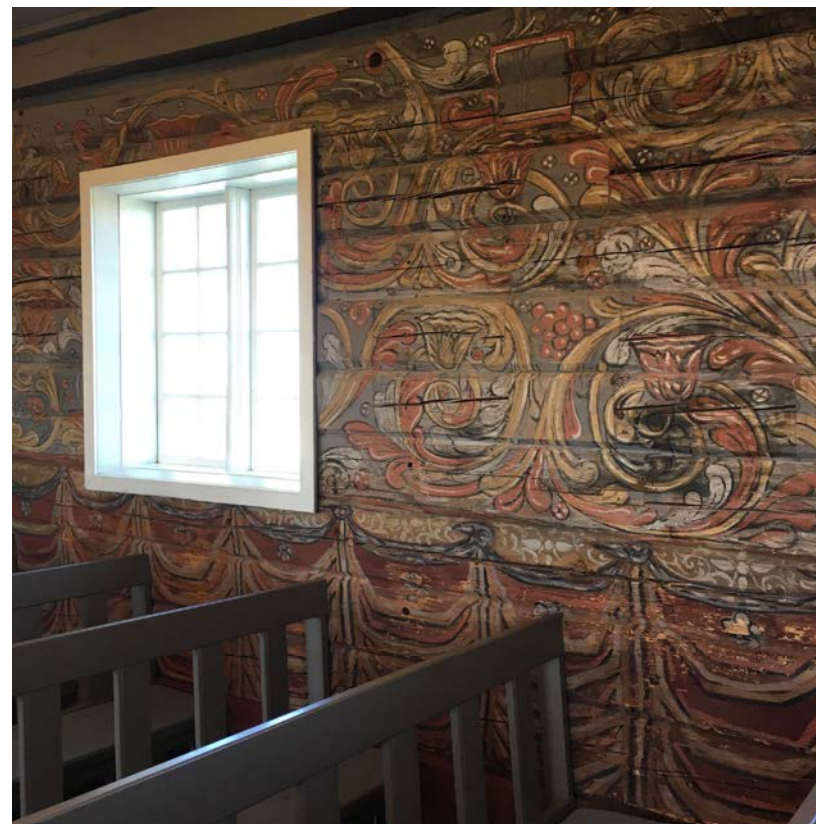
Foto: De originale tømmerveggene i langskipet, TRAFØ
