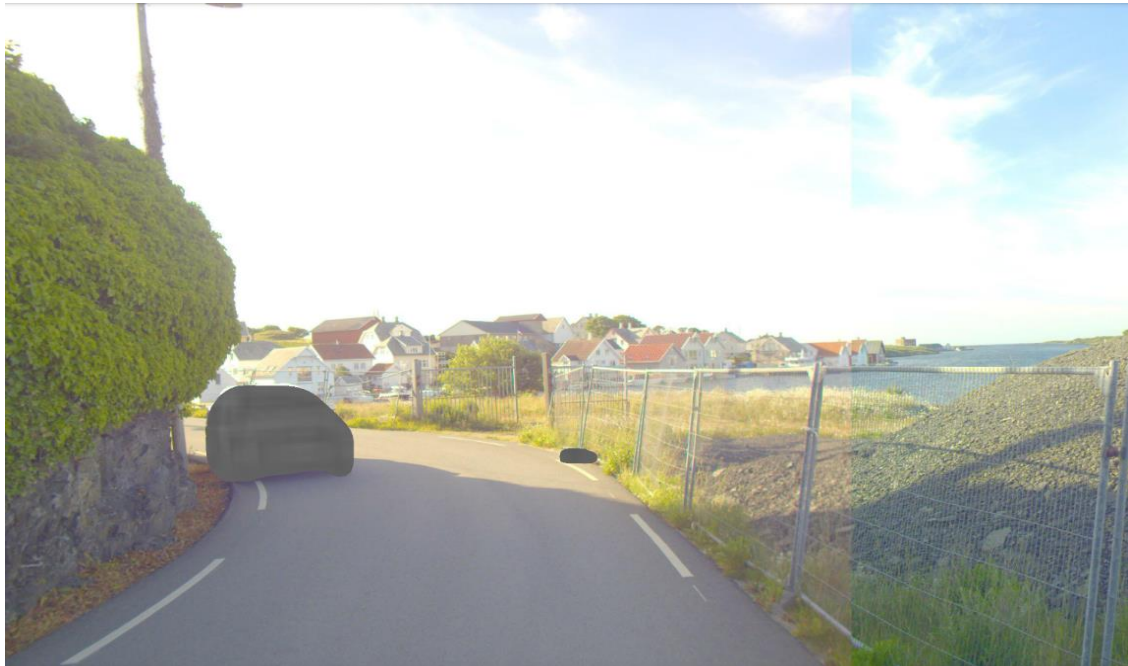
Figur 13: Krapp kurve med dårlig sikt på Hellesøy. Utklipp fra vegkart.no
