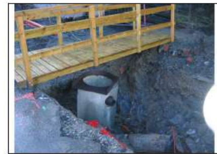
BUNNPLATE MONTERT PÅ KUM Ø650
