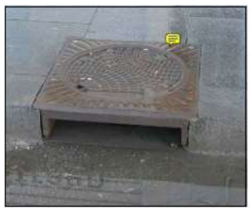
FERDIG MONTERT SLUK I GRANITTDEKKE
