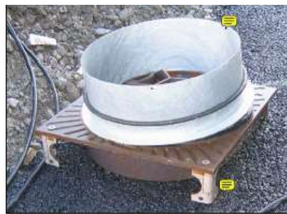
TOPPLATE PÅMONTERT STØTTEBEN (IKKE ORIGINALT)
