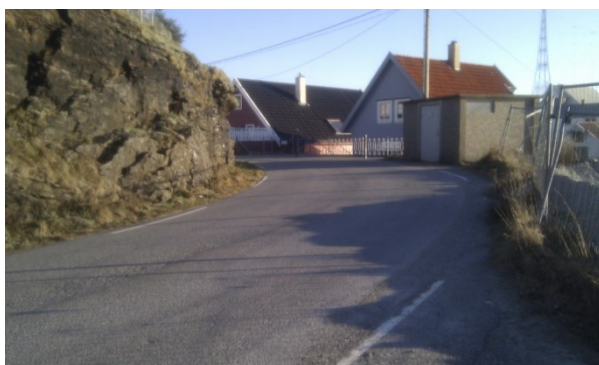
Utstikkende berg og krapp sving ved innkjørselen mot Leiasundet.
